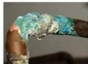
أنابيب نقل المياه
